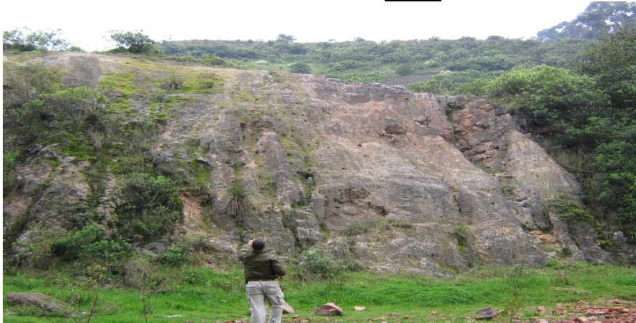
Fotografía No. 1. Se observa el retiro manual de los bloques que potencialmente se encontraban inestables, en el talud que no fue afectado por la antigua actividad minera
